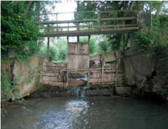
Le seuil des Treize Saules, vanne ouverte avant les travaux de restauration. Printemps 2009
