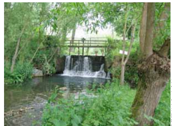
Le seuil des Treize Saules avant ouverture de la vanne. Printemps 2008
