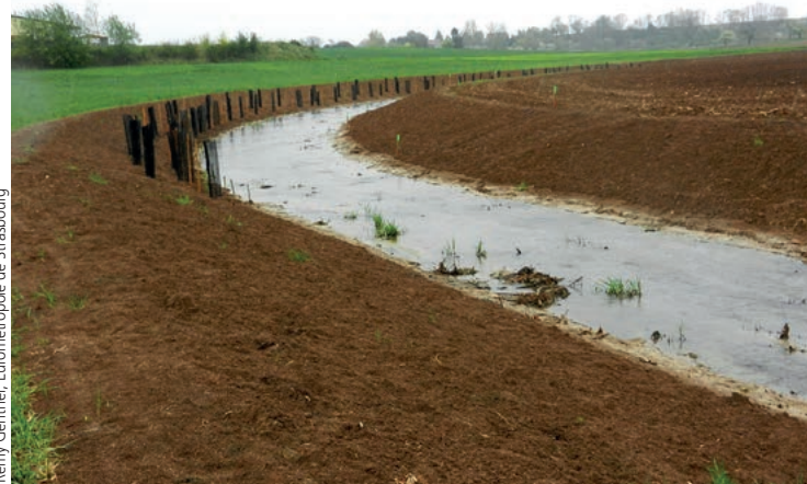
Le Neubaechel juste après les travaux.
