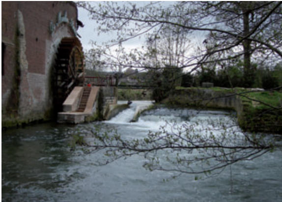
Passage à poissons réalisée au niveau du Moulin Snick
