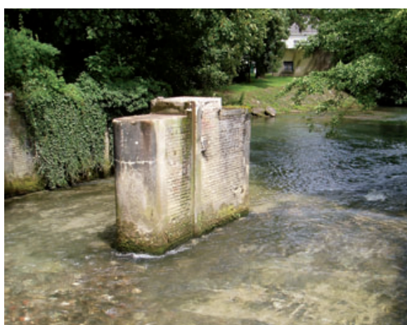
Ouvrage du Moulin de Sill après démantèlement des vannes. Juillet 2010
