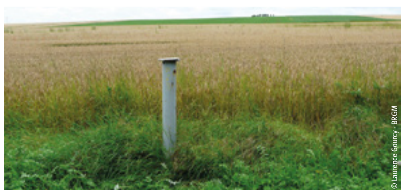
Piézomètre installé dans la nappe alluviale de la Bassée
