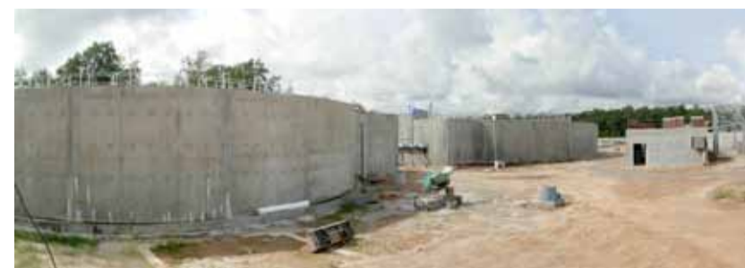
Station d'assainissement de Cayenne en construction
