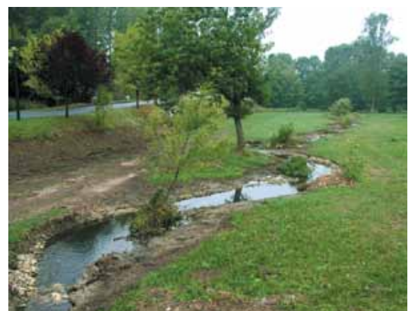
La restauration doit permettre le rétablissement de la dynamique fluviale. Un exemple de cours d'eau reméandré : l'Orfeuill après travaux (Indre-et-Loire).
